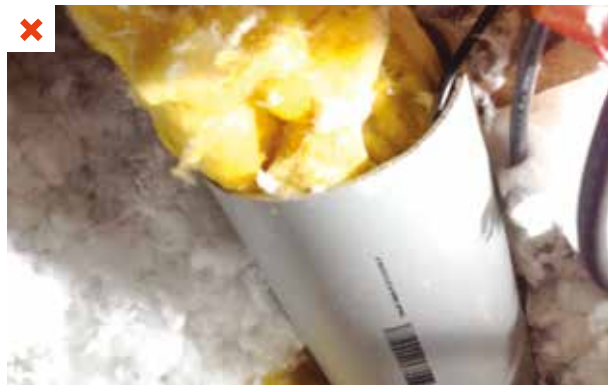
Des tubes en PVC remplis de laine de verre font office de protection des spots encastrés. ©AQQC
