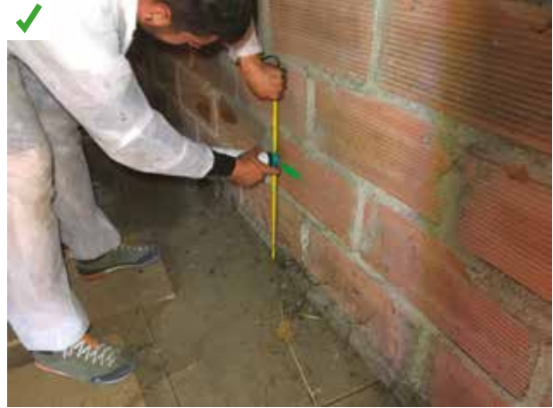
Plusieurs repères à la bombe de peinture fluo sont tracés sur les murs pour contrôler la mise en œuvre de la bonne épaisseur d'isolant. ©AQC
