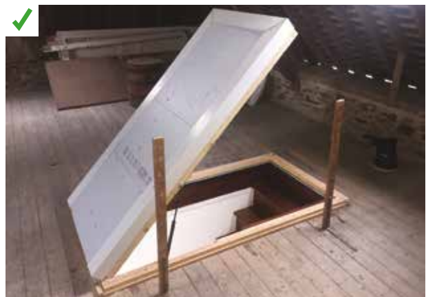
Mise en place d'une trappe d'accès aux combles isolée. Un coffrage sera réalisé autour pour contenir l'isolant soufflé. ©AQC
