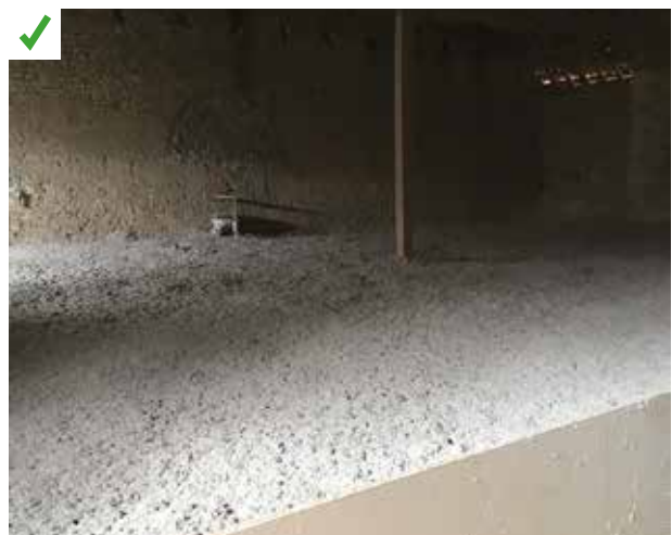
Délimitation de la zone isolée à l'aide d'une plaque verticale pour contenir l'isolant. ©AQC
