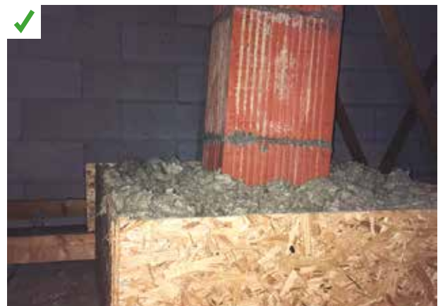
Le coffrage réalisé pour assurer l'écart au feu est rempli d'un isolant incombustible. Le pont thermique a pu être évité. ©AQC
