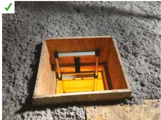
L'isolant soufflé est contenu au niveau de la trappe par un coffrage périphérique rigide. ©AQC
