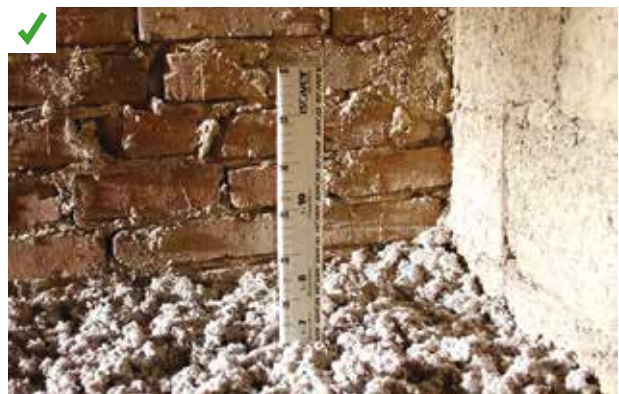
Repérage ponctuel de la hauteur à souffler à l'aide d'une pige. ©AQC
