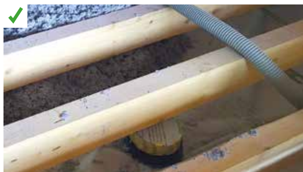
Un capot de protection adapté recouvre le spot encastré. Le traitement de l'étanchéité à l'air englobe le dispositif. ©AQQC
