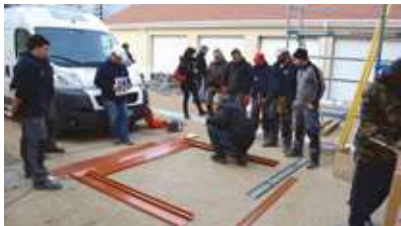
Démonstration du montage du système d'étanchéité au sol
