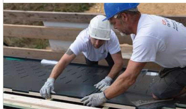
Pose sur ardoise d'un système Solterre Premium sur une maison individuelle en Normandie (14)
