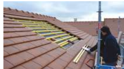
Accompagnement du couvreur lors de l'installation du support
