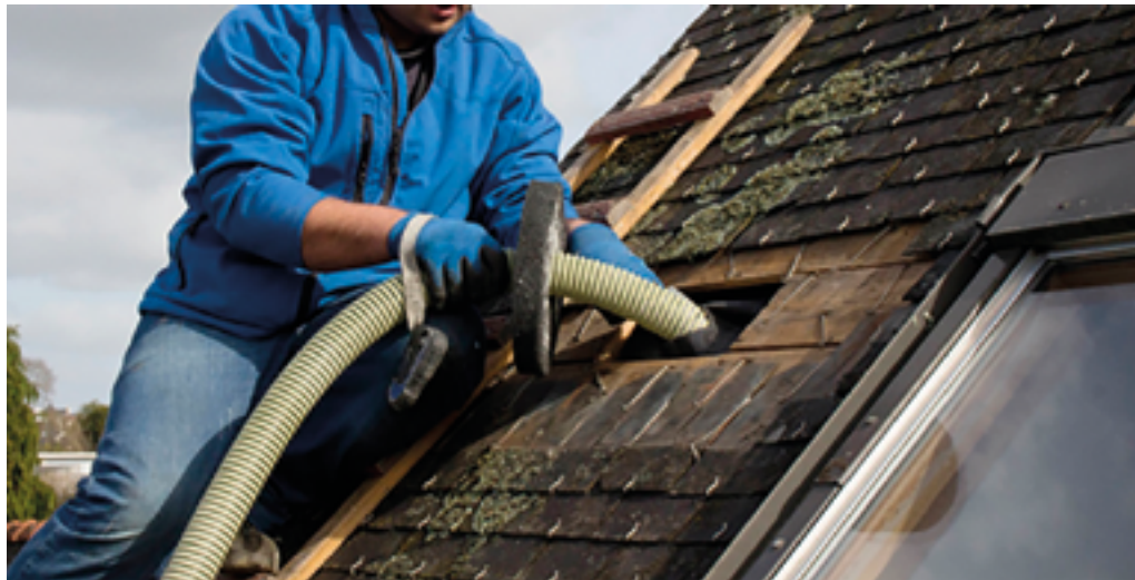
La technique consiste à insuffler, à l'aide d'une machine électrique, la laine de roche en vrac Rockin L dans les sacs Rockbag.
