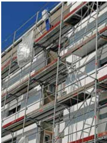
Organiser la récupération des déchets, et notamment des chutes de découpe d'isolant, au fur et à mesure de leur production dans un contenant approprié (benne, caisse, sac polyane...) afin d'éviter les postures contraignantes pour les récupérer au sol ; cela limite également les manutentions pour les emporter dans la benne de tri correspondante ainsi que les opérations de nettoyage de la zone de chantier si des chutes d'isolant sont dispersées.
