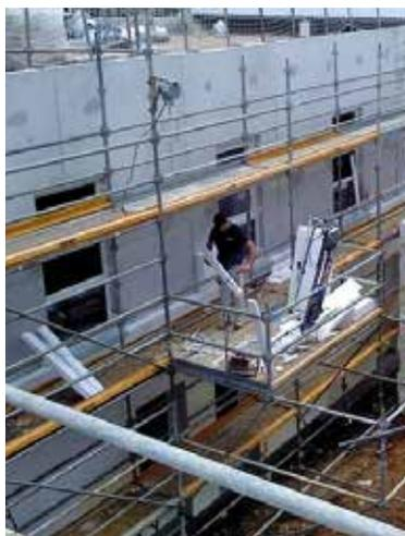
Si l'environnement, le site, la configuration et la hauteur du bâtiment le permettent, une stabilisation de l'échafaudage par **contre-sapines** extérieures :
