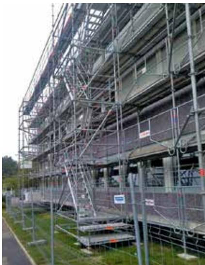
Privilégier l'accès aux différents niveaux par un **escalier** situé à l'une des extrémités de l'échafaudage, notamment si les possibilités d'emprise au sol sont suffisantes ; ou, si cela est possible, équiper l'échafaudage d'un **ascenseur de chantier**.
