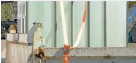
Enfin, le choix de **fixations femelles d'ancrage** avec rupteur de pont thermique simplifie la phase de traitement des ancrages lors du démontage de l'échafaudage et améliore la performance des travaux réalisés.
