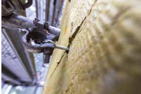
◀ Certains dispositifs d'ancrage sont constitués d'une fixation femelle avec rupteur de pont thermique et d'un piton, favorisant un traitement des ancrages plus rapide. En effet, au démontage, le piton est enlevé, la fixation femelle est rebouchée à l'aide d'un capuchon adéquat, puis la finition est appliquée localement.
