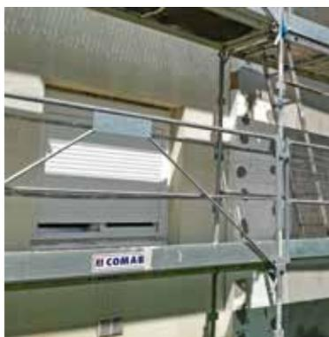
L'installation de dispositifs de protection contre les chutes côté façades et pignons est obligatoire compte tenu de la distance entre les planchers d'échafaudage et la façade ou le pignon, supérieure à 20 cm en début de travaux. Différentes solutions existent :
