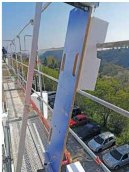
◀ Sur un échafaudage de pied, certains équipements légers, tels que les machines de découpe au fil chaud du polystyrène, peuvent être utilisés au poste de travail.
